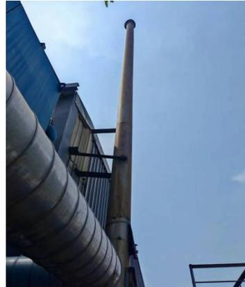
捏合、加压成型工序排气筒 P1
